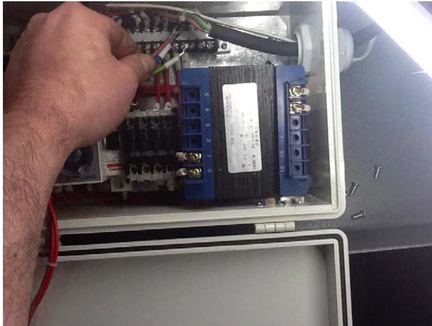
Schliessen sie nun die 6 mtr langen Netzkabel mit dem Elektrokasten L , N, Pe
